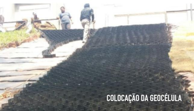
A geometria da face do talude foi recuperada e não houve mais risco de escorregamento de terra.
