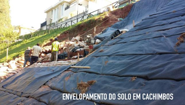
A técnica consiste em envelopar camadas de aterro com um geossintético de reforço para obter um resultado combinando-se fatores como:
